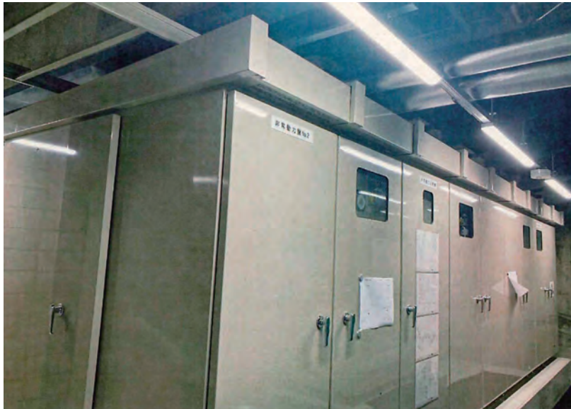
第1変電室トランス更新外電気設備工事
